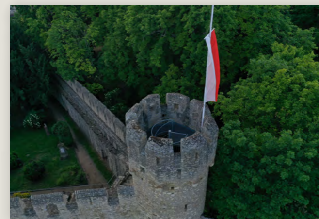
Luftbild von der Drohne aus: Umwehrung der Burgkirche mit Nordturm. Aus einer Vielzahl von Fotografien aus unterschiedlichen Blickwinkeln wird ein digitales 3D-Modell zusammengesetzt. Bei der Erfassung der Maueraufsichten kommt die Drohne zum Einsatz.
